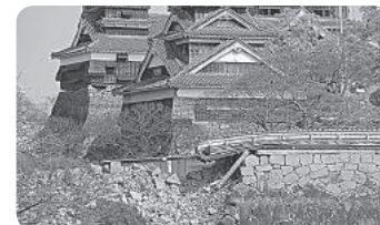
熊本城の被災跡・復旧状況を視察（場所：熊本城）
